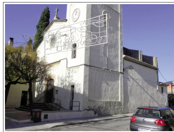
SANT MARTÍ DE SORBET. Església actual. La façana on hi ha l'entrada és la que podria coincidir amb la façana de migdia de la romànica. A sota del campanar hi ha les restes de l'absis.
