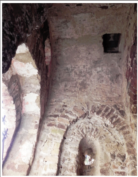
SANT FERMÍ I SANT PERE DE RELLINARS. Volta del cos trapezoïdal i arcs torals. A l'esquerra hi ha l'absis, al davant l'arc former de reforçament del mur de migjorn.
