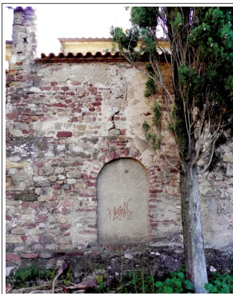
SANT MARTÍ DE SORBET. Façana de ponent en el lateral de l'església actual.
