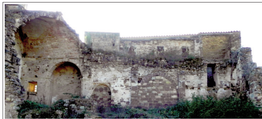
SANT FÈRM I SANT PERE DE REL·LINARS. Alçat interior del mur de migjorn de la nau de tramuntana.
