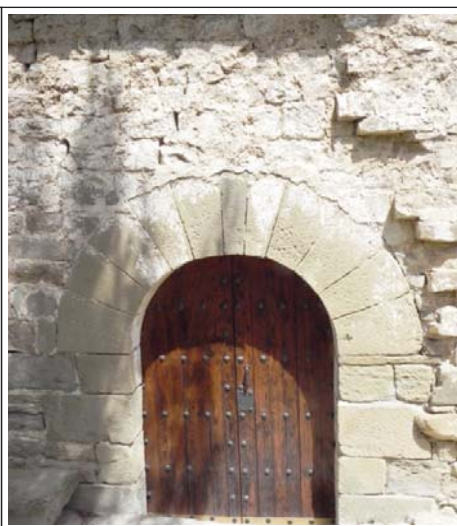
SANT PERE DE VALLHONESTA. Portal i unió amb el mur del segle XII.
