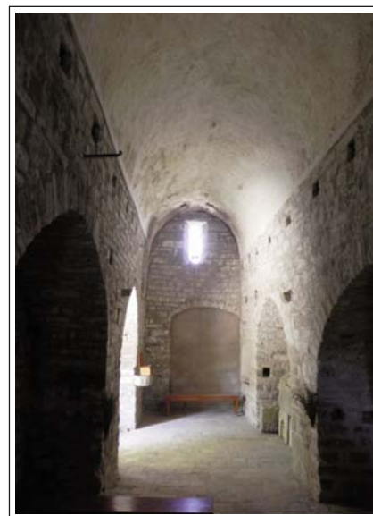
SANT PERE DE VALLHONESTA. Interior de la nau amb els arcs de reforçament i el mur de ponent.
