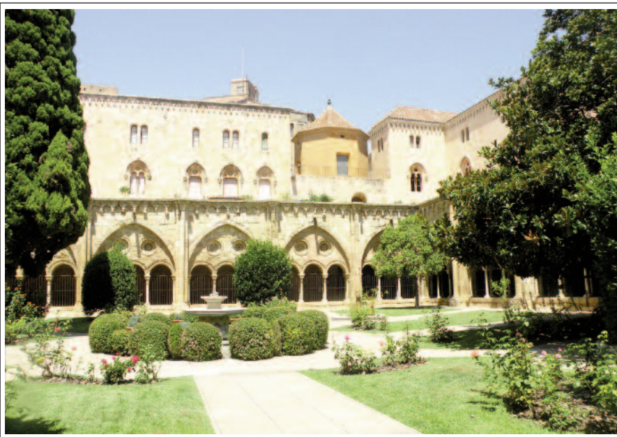
CATEDRAL DE SANTA MARIA. TARRAGONA. Claustre. Interior.
