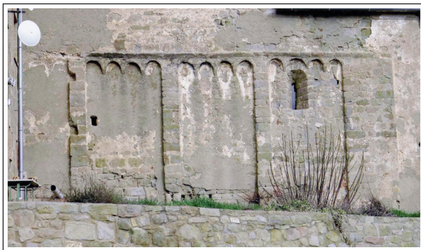
SANT MIQUEL DE CASTELLADRALL. Façana de migdia o sud.
