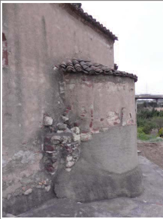
SANT QUINTÍ. Detall de l'absidiola enganxada a les restes del mur de la nau anterior a l'actual.
