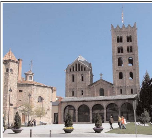
SANTA MARIA DE RIPOLL. Façana.
