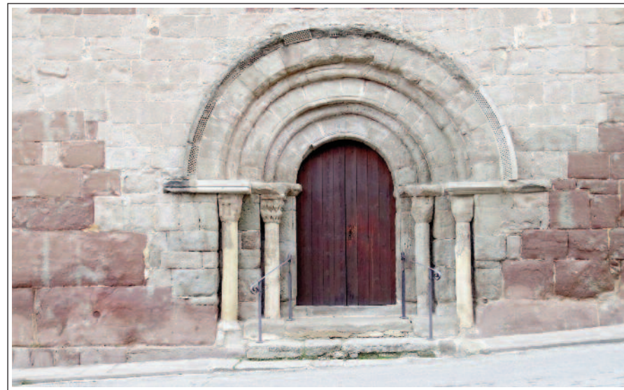
SANT MARTÍ DE PUIG-REIG. Façana de ponent. Portal. Carreus exageradament grans de pedra vermellosa, situats a banda i banda del portal.
