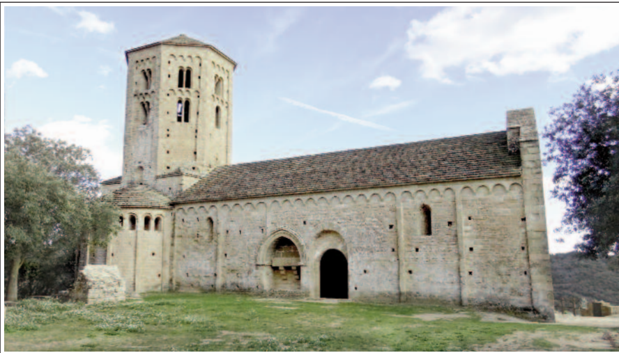
SANT PERE DE PONTS. Façana nord.
