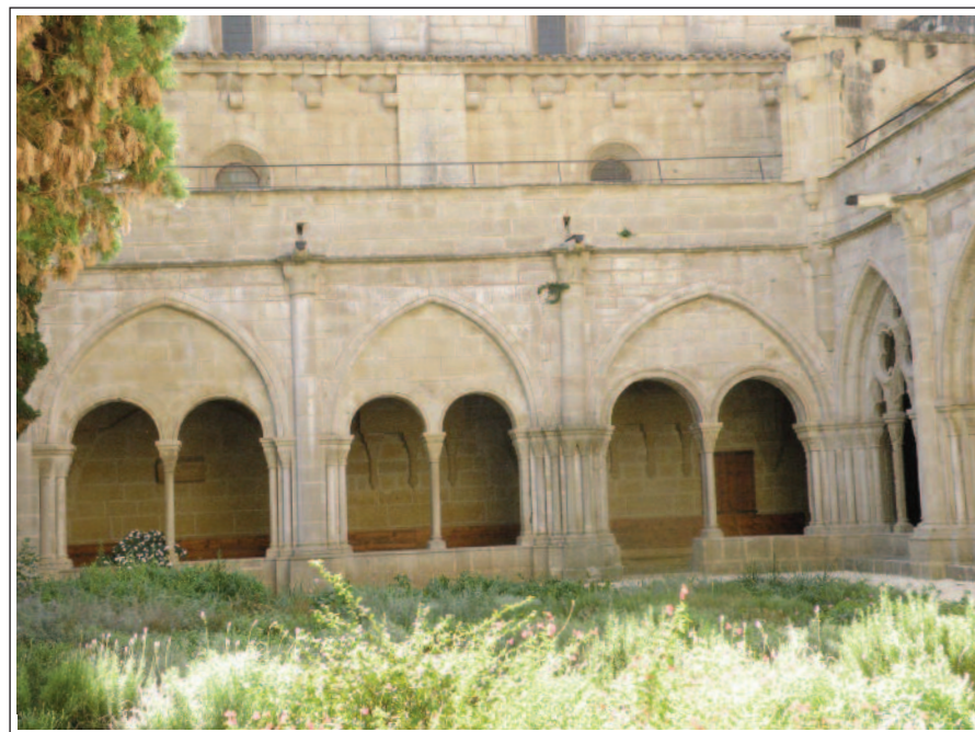
SANTA MARIA DE POBLET. Interior del claustre
