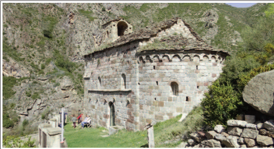
SANTA MARIA D'ARBOLÓ. Absis i façana sud.
