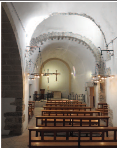
SANTA CREU D'OLORDA. Interior de la nau
