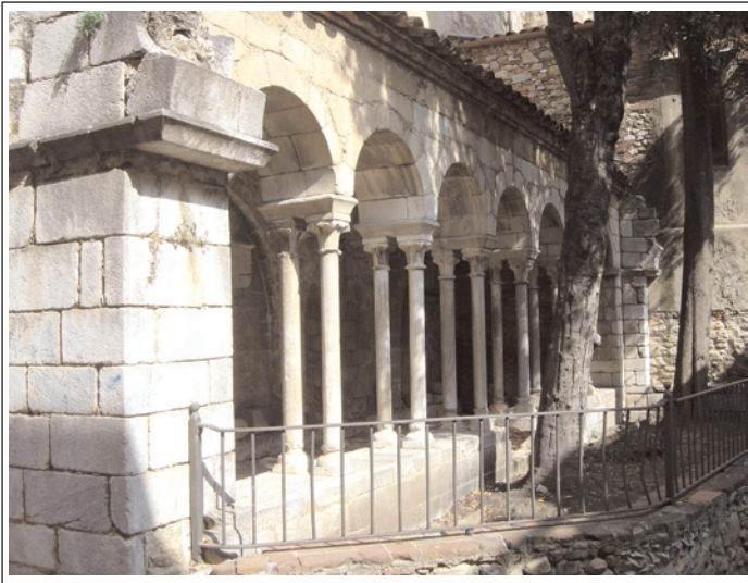
BREDA. Única galeria que resta de l'antic claustre de l'església de Sant Salvador. Està adossada a la façana de migdia.
