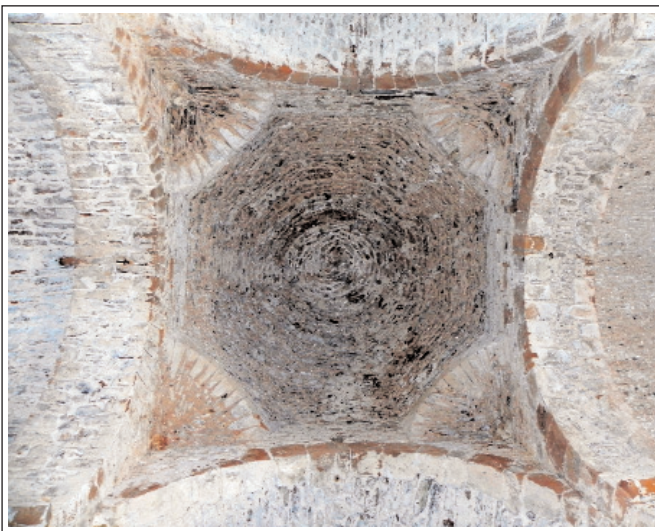
MONESTIR DE SANT LLORENÇ DEL MUNT. Volta del cimbori.
