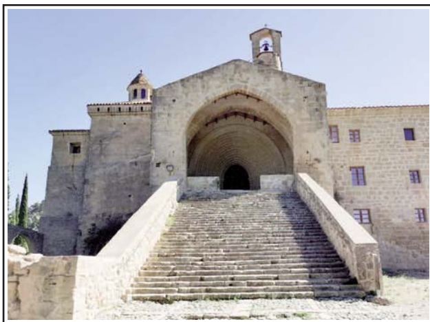
ESGLÉSIA DE LA MARE DE DÉU DELS ÀNGELS o de SANT SALVADOR.
