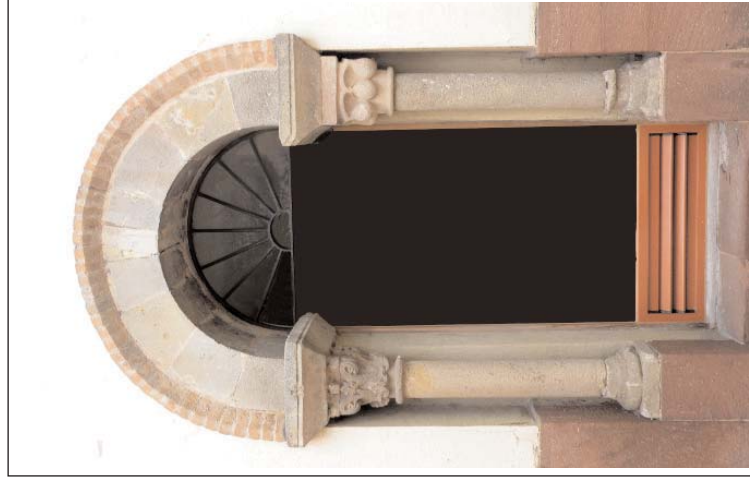
CASA MUSEU SANTACANA. L'ENRAJOLADA. Martorell. Portal romànic del claustre de Santa Maria de les Puelles instal·lat a l'exterior del Museu.
