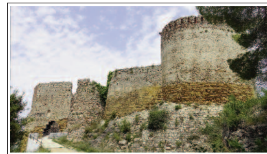
CASTELL DE GELIDA. Mur i torre del recinte superior. Foto: 2021
