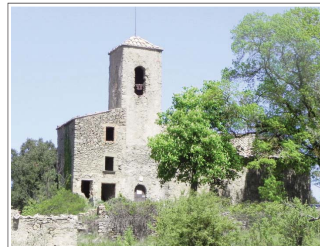
SANT JULIÀ D'ÚIXOLS. Façana des de migjorn.
