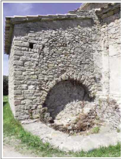
SANT SADURNÍ DE GALLIFA. Cos de migdia amb les restes de l'absis i el paredat de l'arcada d'unió.
