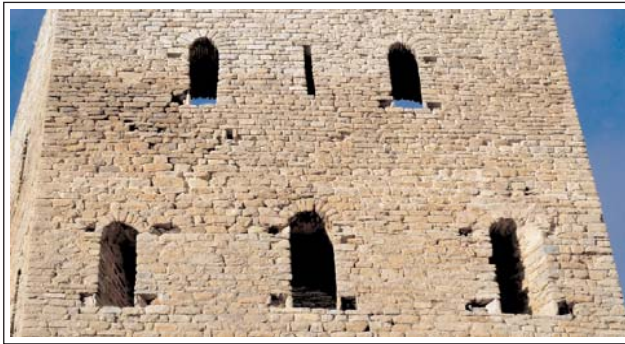
TORRE DEL CASTELL DE LLUÇARS. Detall de les obertures del cap de dalt
