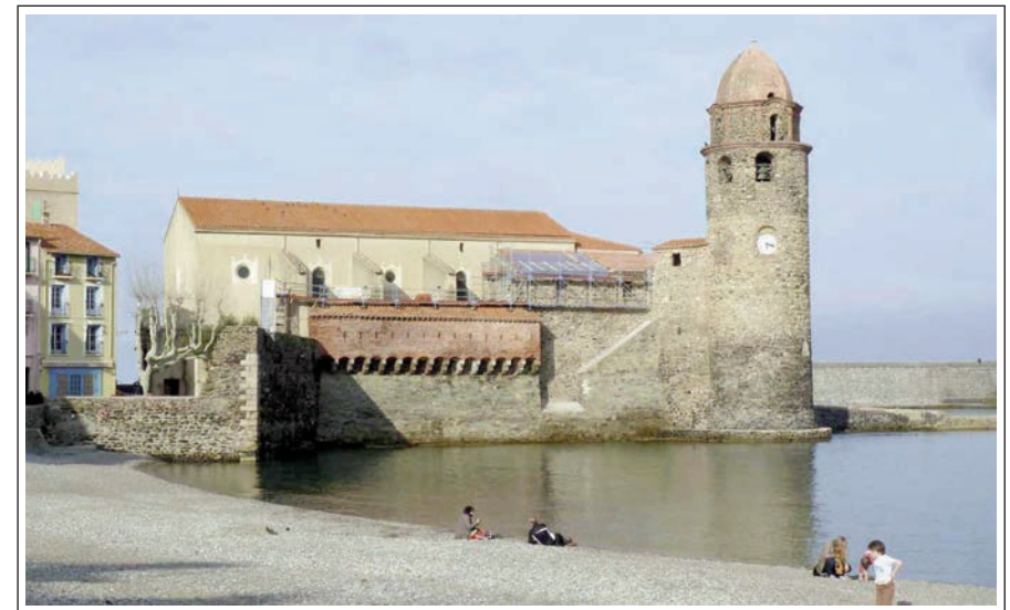
COTLLIURE. Església amb el campanar construït damunt d'un antic far medieval.
