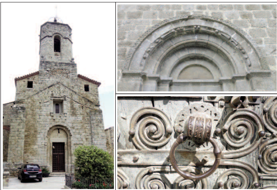
SANT MARTÍ DE MASSANET DE CABRENYS amb detalls del portal de migdia i de la ferramenta de la porta.
