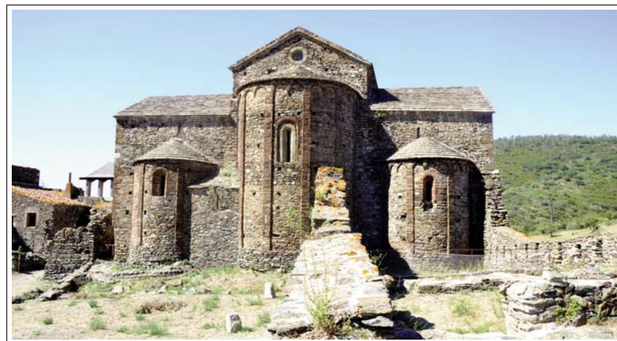
SANT QUIRZE DE COLERA. Exterior dels absis i transepte.
