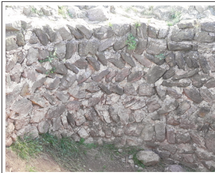
TORRE ROJA. Aparell en opus spicatum del parament interior de la torre.
