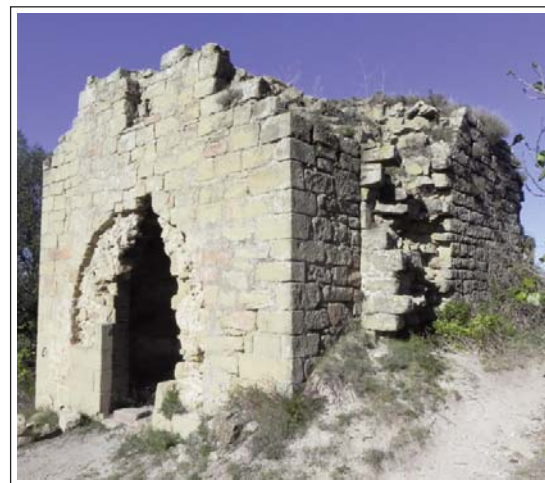
CASTELL DE CASTELLCIR. Capella de Sant Martí adossada a la torre de l'extrem nord-est. Les restes d'aquesta torre, les podem veure en el mur de la dreta. També hi veiem l'empremta de la portalada que avui és a Mura.
