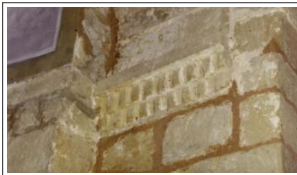
SANT ANDREU DE CASTELLCIR. Detall d'un frís escacat que se situa a l'arrencada de l'arc triomfal de les dues absidions.
