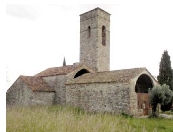
SANT ESTEVE DE CASTELLAR VELL. Façana nord.
