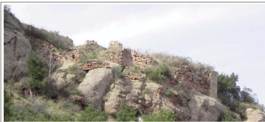
CASTELL DE PERA. Muralles que tanquen el sector de llevant. a l'esquerra rampa escalonada d'accés i a la dreta el mur transversal
