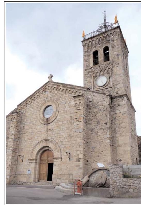
SANT MIQUEL DELS ÀNGLES. Església neoromànica, edificada aprofitant una bona part dels carreus i pedres esculpides de l'antiga església de Sant Salvador que era situada molt a prop.
