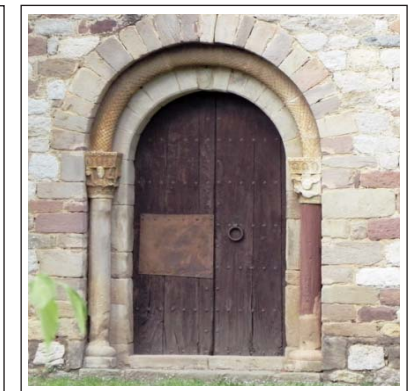
SANTA MARIA DEL CAMÍ. Portal.
