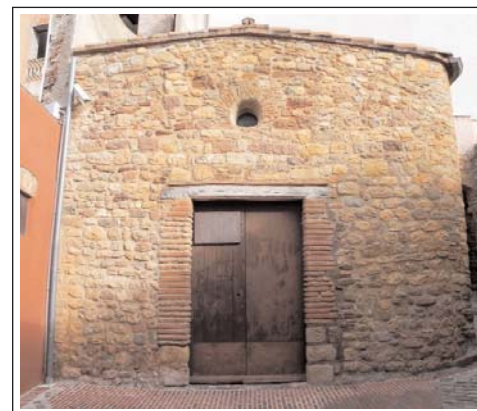
SANTA SUSANNA. Estat actual de la façana de tot, encara es detecta el coronament a dues aigües de la façana original. Aquest aparell és característic dels edificis del romànic meridional i que solen ser datats entre el final del segle XI, fins a mitjà del XII.
