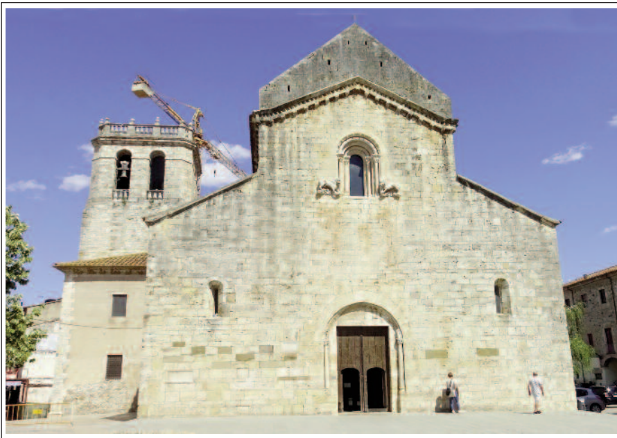
SANT PERE DE BESALÚ. Façana principal
