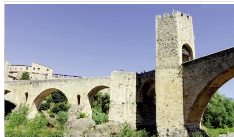
PONT VELL. A l'esquerra els arcs romànics reconstruïts
