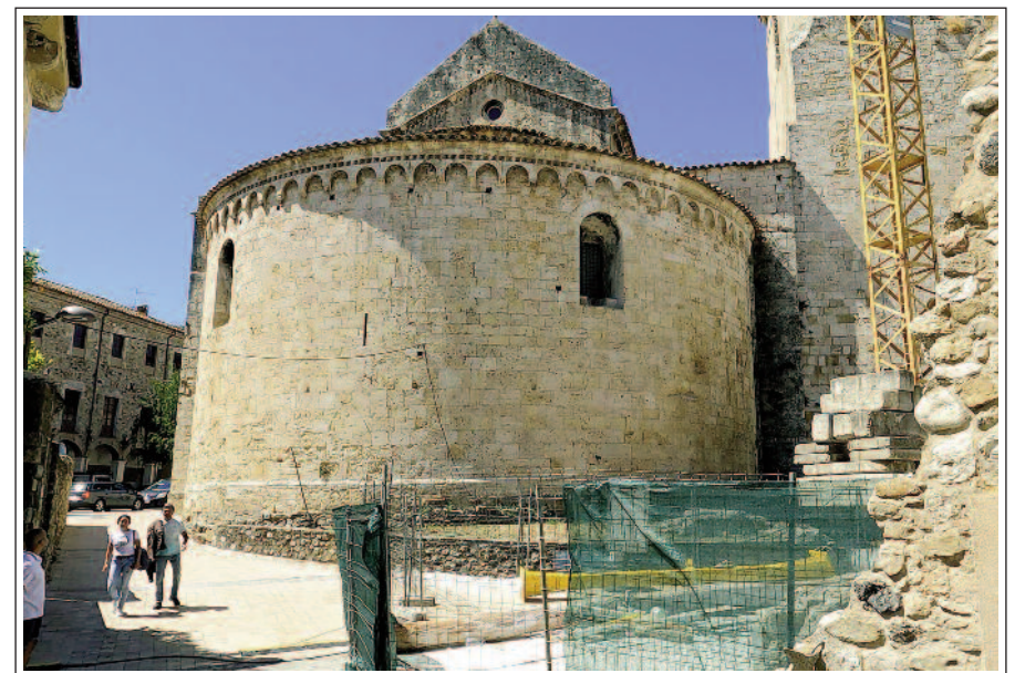
SANT PERE DE BESALÚ. Les obres actuals permeten de veure l'absis complet.
