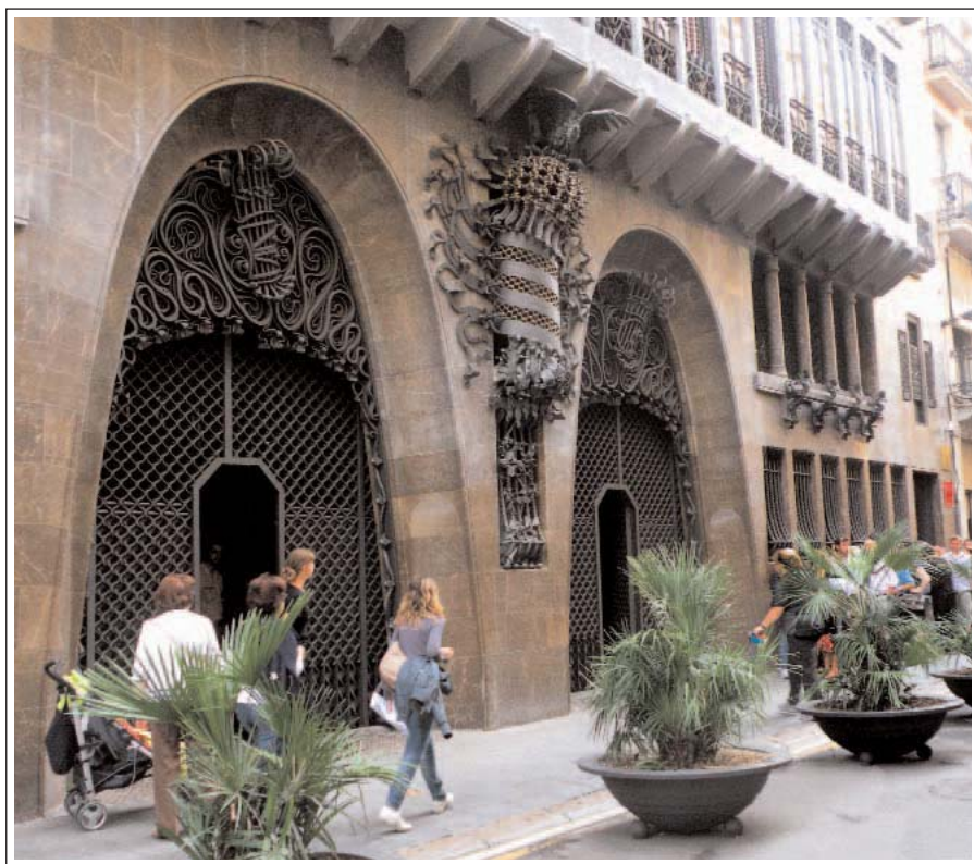
PALAU GÜELL. Portalades de la façana principal
