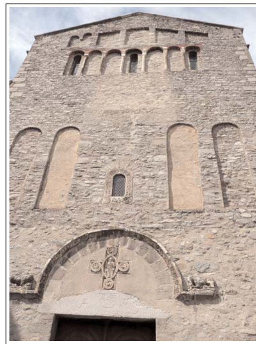
SANTA MARIA D'ARLES. Façana principal.
