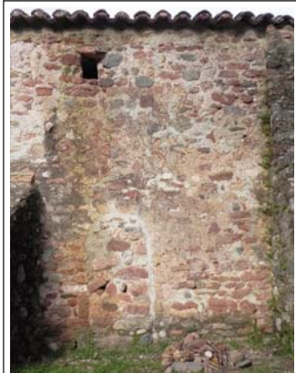
SANTA MARIA DE LES ARENES. A dalt Façana de garbí, sector central, on hi ha la porta. A baix la mateixa façana, sector central on hi ha la porta romànica.
