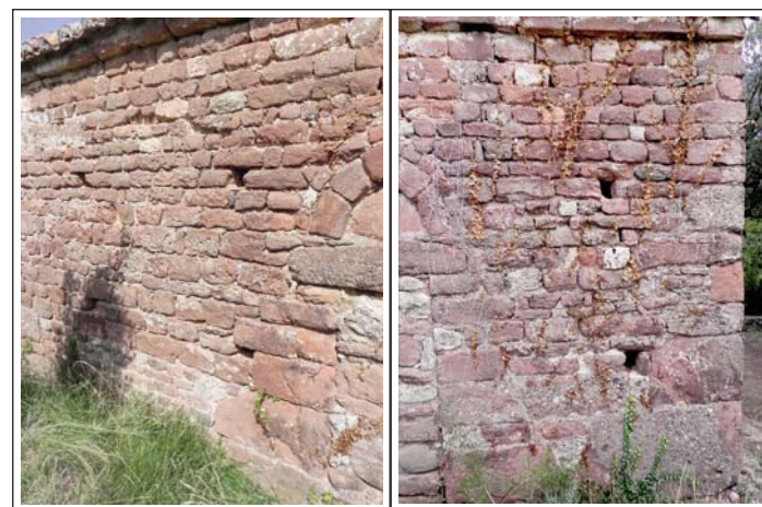
SANT PERE DE MUR o del DALMAU. A l'esquerra, detall de l'aparell de la façana de migjorn, zona ponent. A la dreta detall de l'aparell de la façana de migjorn, zona de llevant.
