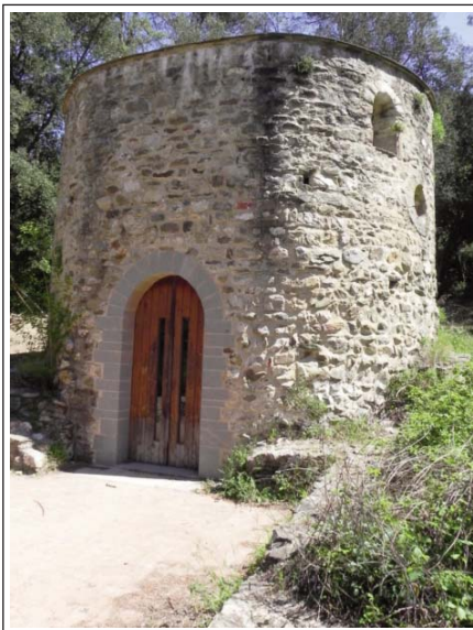
SANT ADJUTORI. Costat de ponent, la porta se situa en l'esvoranc que es va obrir per connectar la capella amb la nau del segle XVII i quedar aquella com a absis.
