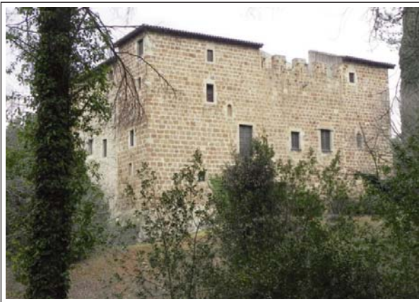
TORRE NEGRA. Façana de ponent.
