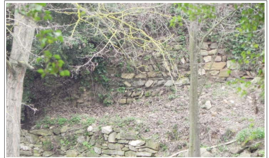
TORRE NEGRE. Marge amb pedres en "opus spicatum".
