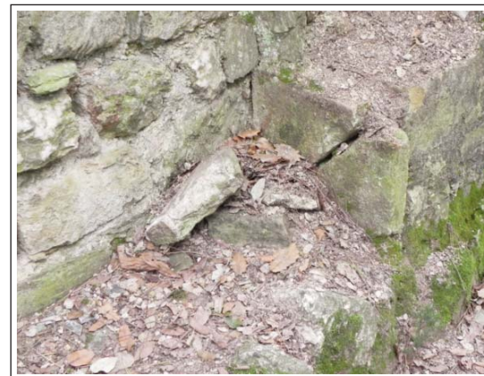
SANT VICENÇ DEL BOSC. Detall de les peces triangulars del revestiment ceràmic del mur arran de l'arc triomfal.
